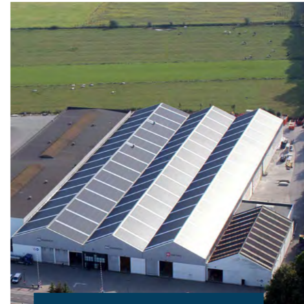
Batiments industriels avec solutions éclairantes.
