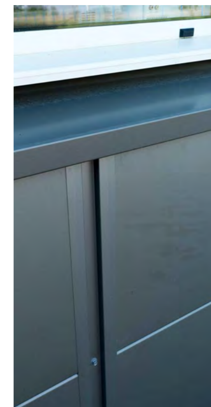
Bavette appui de fenêtre pour secteur tertiaire.
